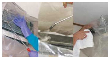
フィンの汚れもすっきり エアコンクリーニング
